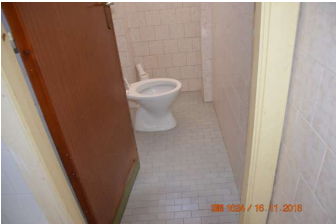
Particolare dello stato attuale dei servizi igienici
